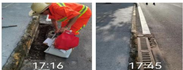
(上图：清掏水篦子前、后，不留卫生死角)
