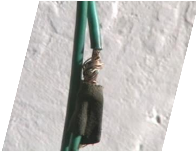
电线破损裸露
