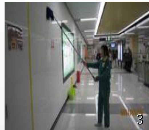
3.把毛巾包住涂水器，用适当的力量在墙面顶端从上而下擦拭，不留死角
