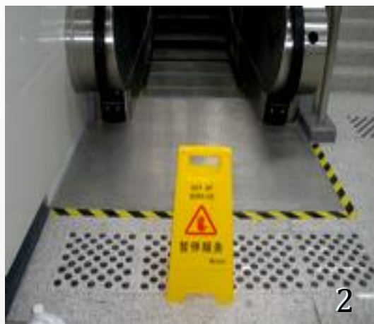
2.向车控室申请停开手扶梯，不能擅自操作，在手扶梯上、下入口处摆放“暂停服务”告示牌
