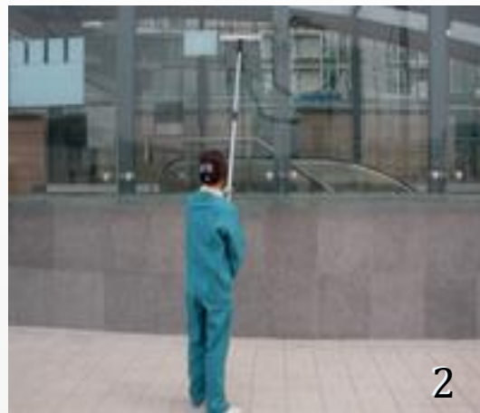
2.把涂水器湿润后擦洗玻璃，用适当的力量在玻璃表面顶端从上而下擦抹，不留死角
